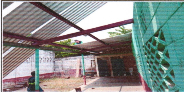
foto 2: 1.2 Sustitución de capote de lamina para lamina troquelada
