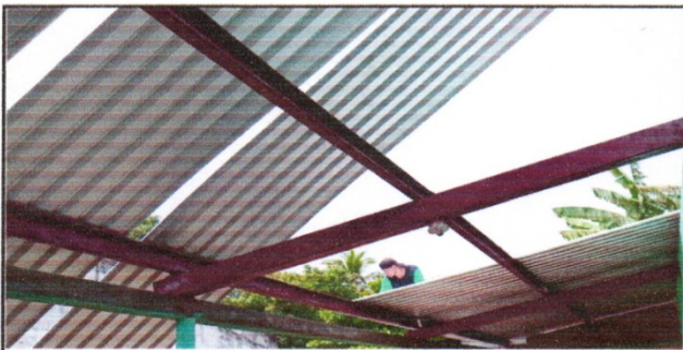
foto 3 2.1 Mantenimiento a estructura de soporte de metal
