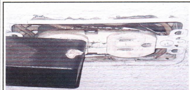
foto 5: 17.8 Sustitución de tomacorrientes dobles
