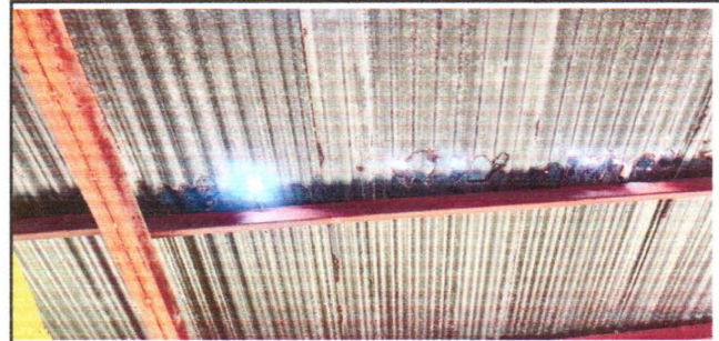
foto 2: 1.2 Sustitución de capote de lamina para lamina troquelada
