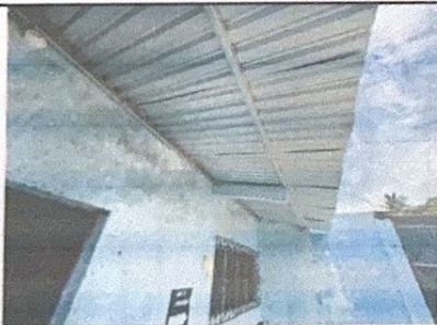
Foto 11: Sustitución de estructura y cubierta de lamina
