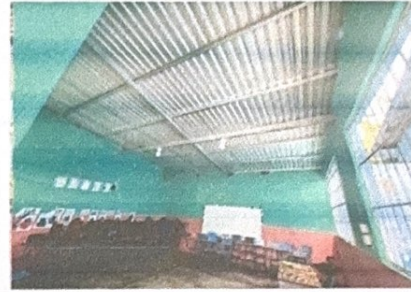
Foto 8: Sustitución de estructura y cubierta de lamina
