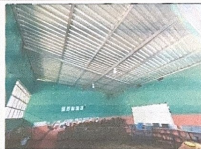
Foto 10: Sustitución de estructura y cubierta de lamina
