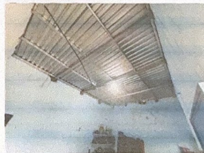
Foto 12: Sustitución de estructura y cubierta de lamina
