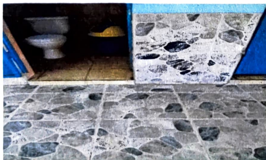
Foto 5: 10.3 SUSTITUCIÓN DE INODORO
