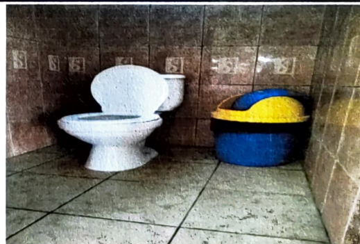
Foto 4: 10.3 SUSTITUCIÓN DE INODORO
