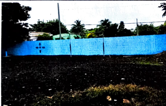
Foto 3: 9.1 PINTURA EN MUROS EXTERIORES E INTERIOS
