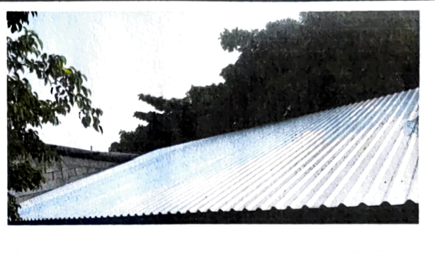
Foto 2: 1.1 SUSTITUCIÓN DE LAMINA, ESTADO ACTUAL
