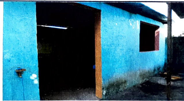
Foto 3: 9.1 PINTURA EN MUROS EXTERIORES E INTERIOS
