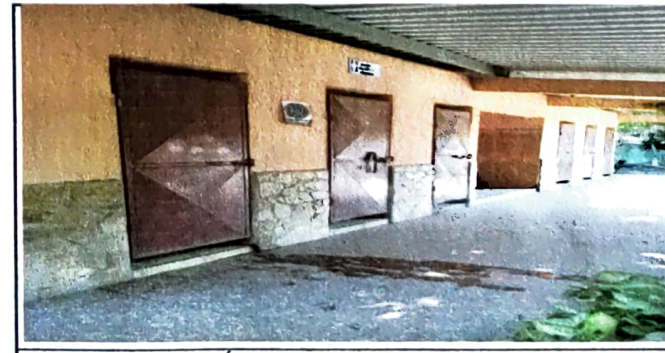
Foto 6: 6.8 SUSTITUCIÓN DE PISO CERAMICO
