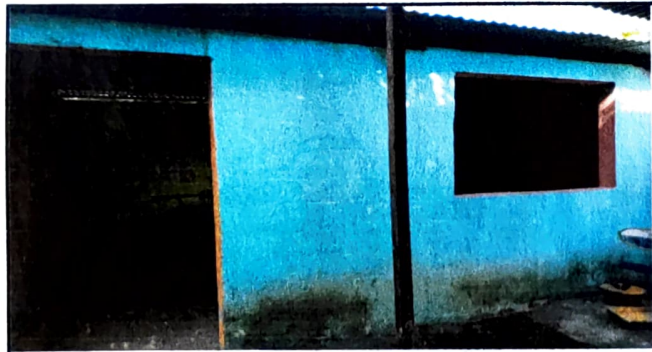
Foto 3: 2.3 SUSTITUCIÓN DE ESTRUCTURA DE PUERTAS DE METAL, ESTADO ACTUAL
