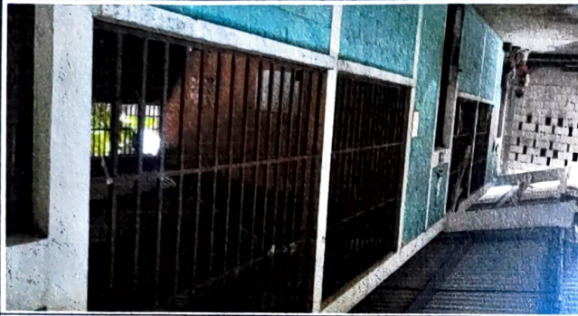
Foto 1: 5.1 MANTENIMIENTO A ESTRUCTURA DE METAL DE VENTANA
