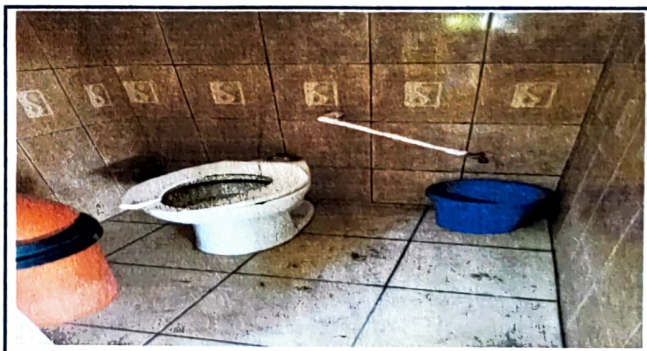
Foto 4: 10.3 SUSTITUCIÓN DE INODORO
