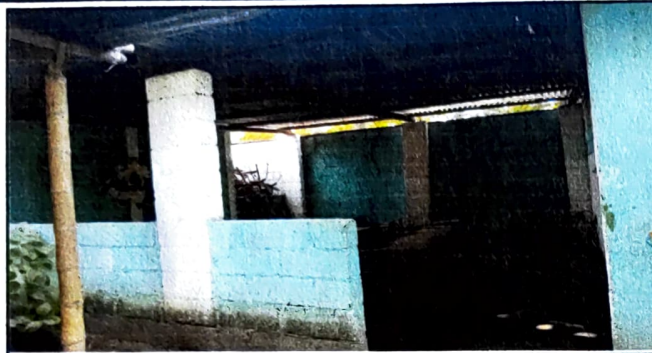
Foto 1: 1.1 SUSTITUCIÓN DE LAMINA, ESTADO ACTUAL
