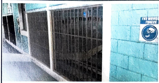
Foto 2: 5.1 MANTENIMIENTO A ESTRUCTURA DE METAL DE VENTANA
