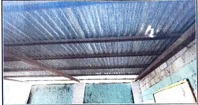
Foto 2: 1.1 SUSTITUCIÓN DE LAMINA, ESTADO ACTUAL
