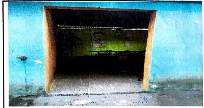
Foto 4: 2.3 SUSTITUCIÓN DE ESTRUCTURA DE PUERTAS DE METAL, ESTADO ACTUAL
