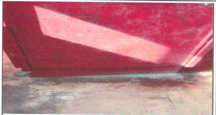
FOTO 2: SUSTITUCION DE PUERTAS EN SERVICIOS SANITARIOS
