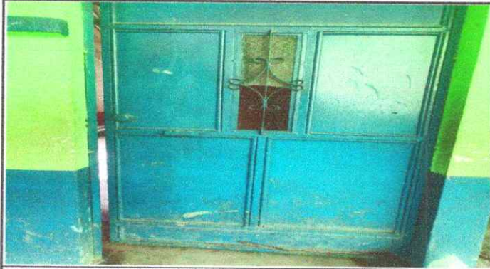
FOTO 1: SUSTITUCIÓN DE PUERTAS
