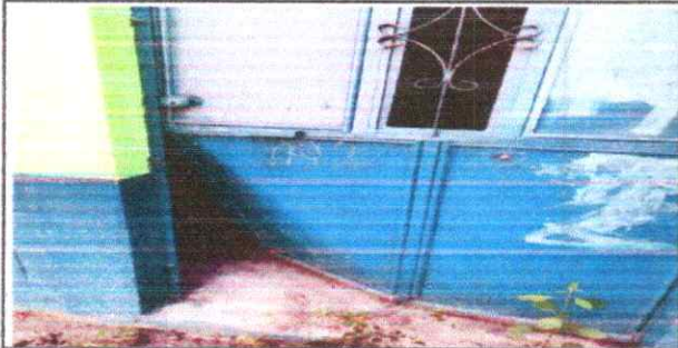
SUSTITUCIÓN DE PUERTAS DE METAL
