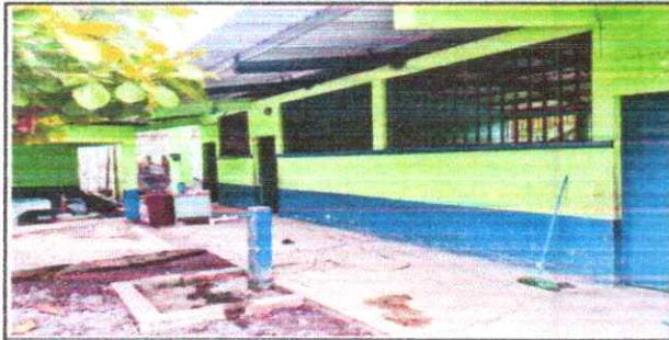
PINTURA DE MUROS INTERIORES
