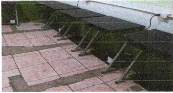
Foto 7: Sustitución de piso cerámico
