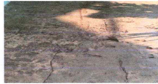
Foto 6: Sustrucción de piso de torta de concreto
