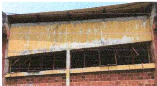
Foto 5: Sustrucción de estructura de metal de ventana
