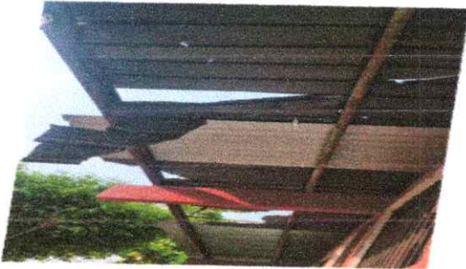
Foto 3: Sustrucción de estructura de soporte de metal, por metal
