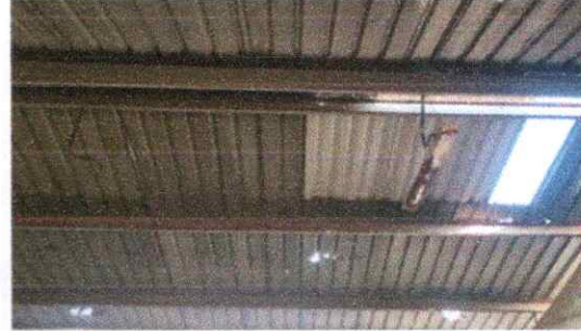
Foto 2: Sustrucción de elementos de fijación
