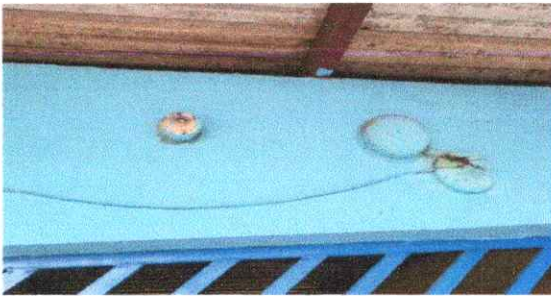
Foto 11: Sustitución de plafoneras
