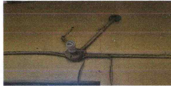
Foto 12: Reparación de cable eléctrico
