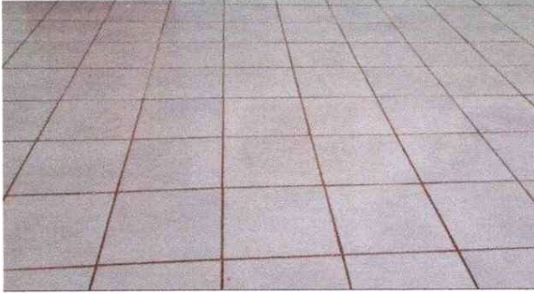
Foto 1: 6 PISO 6.8 Sustitución de Piso Cerámico
