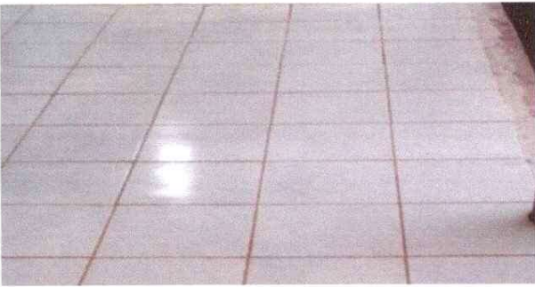
Foto 3: 6 PISO 6.8 Sustitución de Piso Cerámico
