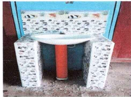
Foto 6: 13. SUSTITUCIÓN DE AZULEJO 13.1 Sustitución de azulejo
