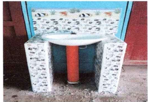
Foto 4: 10 SERVICIOS SANITARIOS Y SUS ACCESORIOS 10.5 Sustitución lavamanos
