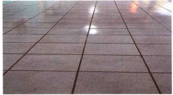
Foto 2: 6 PISO 6.8 Sustitución de Piso Cerámico
