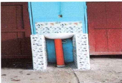
Foto 5: 10 SERVICIOS SANITARIOS Y SUS ACCESORIOS 10.5 Sustitución lavamanos
