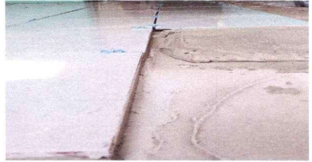
Foto 2: 6 PISO 6.8 Sustitución de Piso Cerámico
