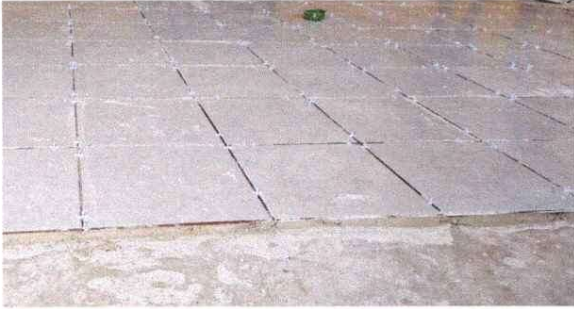
Foto 1: 6 PISO 6.8 Sustitución de Piso Cerámico
