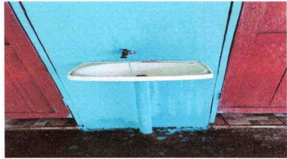
Foto 4: 10 SERVICIOS SANITARIOS Y SUS ACCESORIOS 10.5 Sustitución lavamanos
