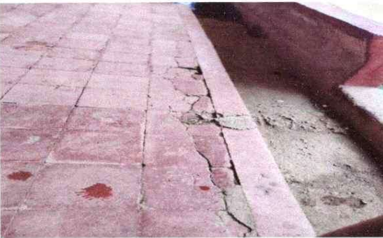
Foto 3: 6 PISO 6.8 Sustitución de Piso Cerámico
