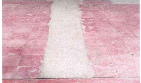
Foto 2: 6 PISO 6.8 Sustitución de Piso Cerámico
