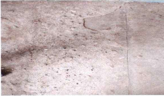
Foto 1: 6 PISO 6.8 Sustitución de Piso Cerámico
