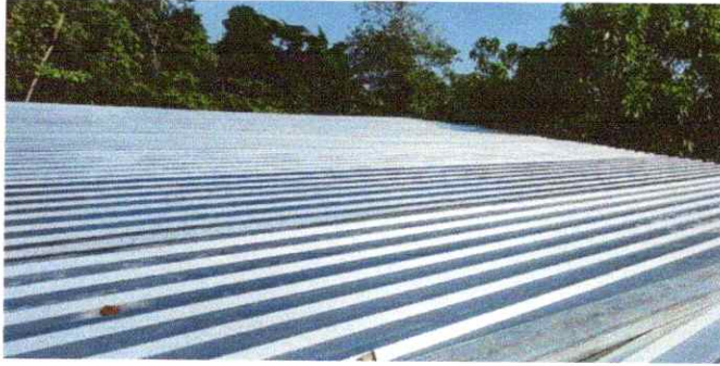
FOTO 1: 1 CUBIERTA DE LAMINA.
