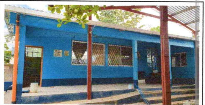
FOTO 6: 7 CANALES Y BAJADAS DE AGUA PLUVIAL
