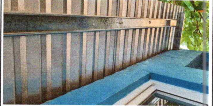
FOTO 2: 2 ESTRUCTURA DE TECHO
