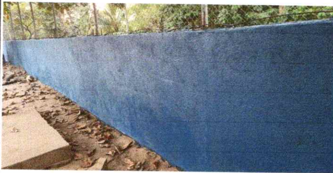
FOTO 7: 9 PINTURA EN MUROS EXTERIORES E INTERIORES. 9.1 Pintura en muros exteriores e interiores
