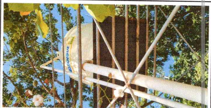
FOTO 8: 18 REPARACIÓN Y MANTENIMIENTO DE CISTERNAS / DEPÓSITO DE AGUA 18.2 Sustitución de depósito de agua 1100 lt.
