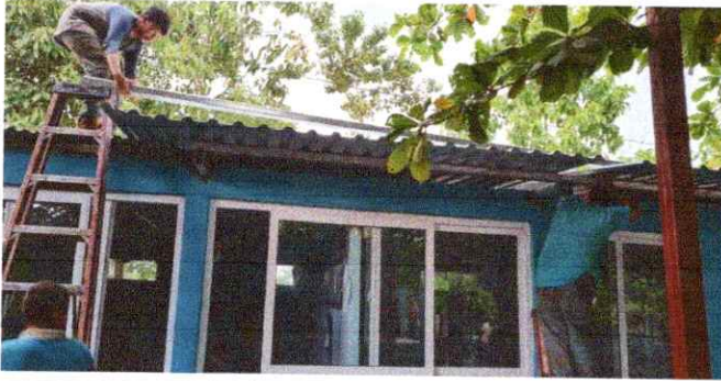
FOTO 1: 1 CUBIERTA DE LAMINA.
