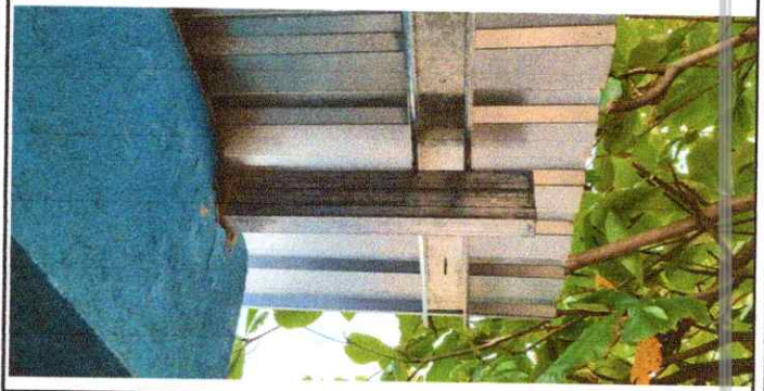
FOTO 2: 2 ESTRUCTURA DE TECHO
