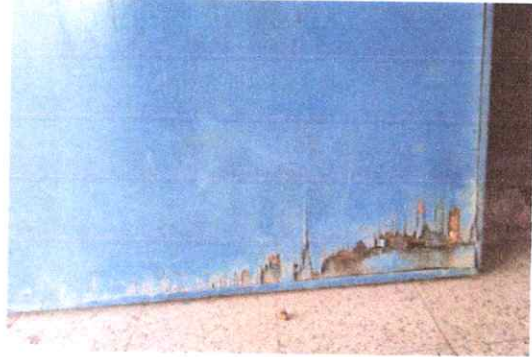
FOTO 3: 4 PUERTAS DE METAL 4.3 Sustitución de puerta
