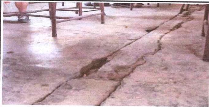
FOTO 5: 6 PISO 6.8 Sustitución de piso cerámico
