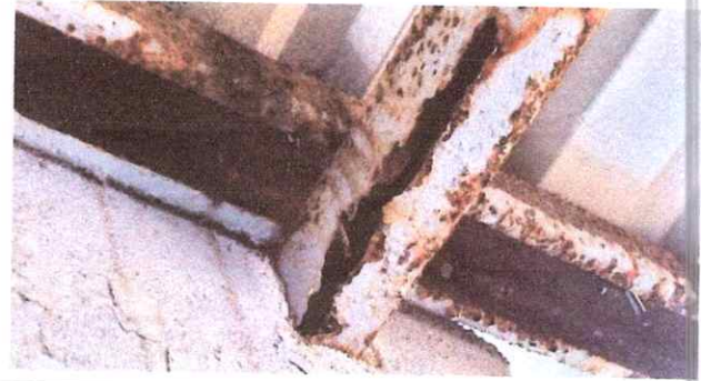
FOTO 2: 2 ESTRUCTURA DE TECHO 2.3 Sustitución de estructura de soporte de metal, por metal
