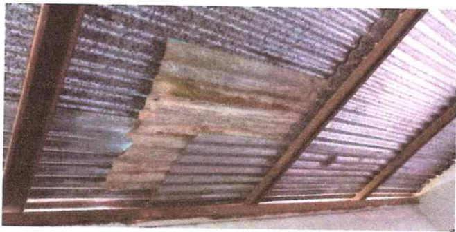
FOTO 1: 1 CUBIERTA DE LAMINA. 1.1 Sustitución de lámina, por lámina troquelada aluzinc calibre 26. 1.3 Sustitución de elementos de fijación.
