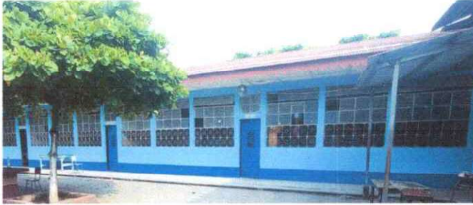
Foto 1: 5 VENTANAS 5.7 Mantenimiento a balcones de metal
