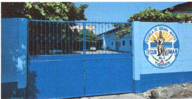
Foto 5: 19 MANO DE OBRA ESPECIALIZADA (ALBAÑILERÍA, HERRERIA, ELECTRICIDAD Y PLOMERIA) 19.5 Fabricación e instalación de portón de metal de ingreso
