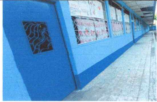
Foto 2: 5 VENTANAS 5.7 Mantenimiento a balcones de metal
