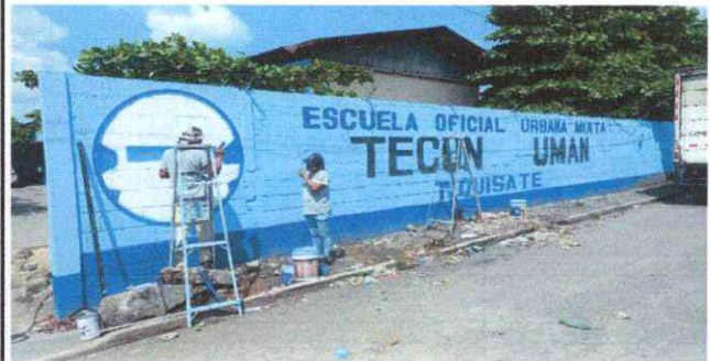
Foto 4: 9 PINTURA EN MUROS EXTERIORES E INTERIORES 9.1 Pintura en muros exteriores e interiores
