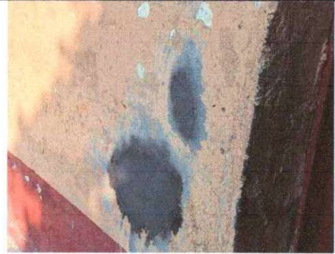
Foto 8: 21 REPARACION DE REPELLO Y CERNIDO DE PAREDES (CUANDO APLIQUE) 21.1 Repello en muro
