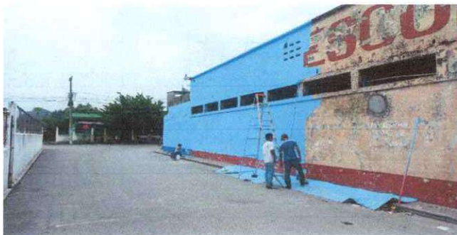
Foto 3: 9 PINTURA EN MUROS EXTERIORES E INTERIORES 9.1 Pintura en muros exteriores e interiores
