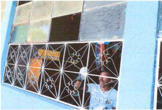
Foto 1: 5 VENTANAS 5.7 Mantenimiento a balcones de metal
