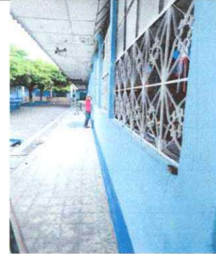
Foto 2: 5 VENTANAS 5.7 Mantenimiento a balcones de metal
