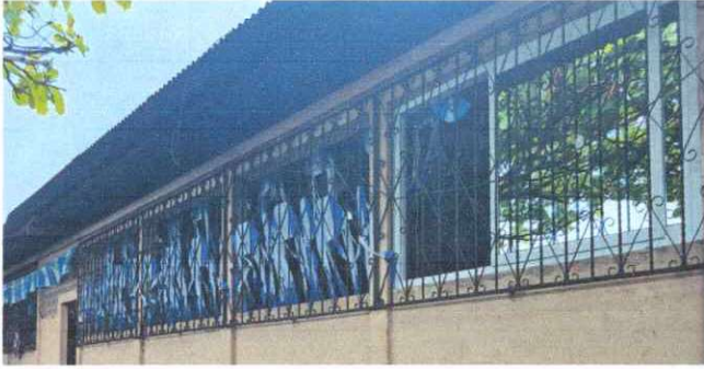
Foto 1: 5 VENTANAS 5.7 Mantenimiento a balcones de metal
