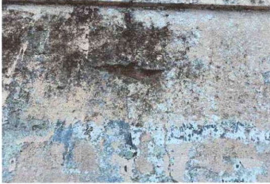
Foto 7: 21 REPARACION DE REPELLO Y CERNIDO DE PAREDES (CUANDO APLIQUE) 21.1 Repello en muro
