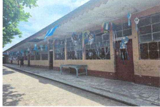
Foto 2: 5 VENTANAS 5.7 Mantenimiento a balcones de metal
