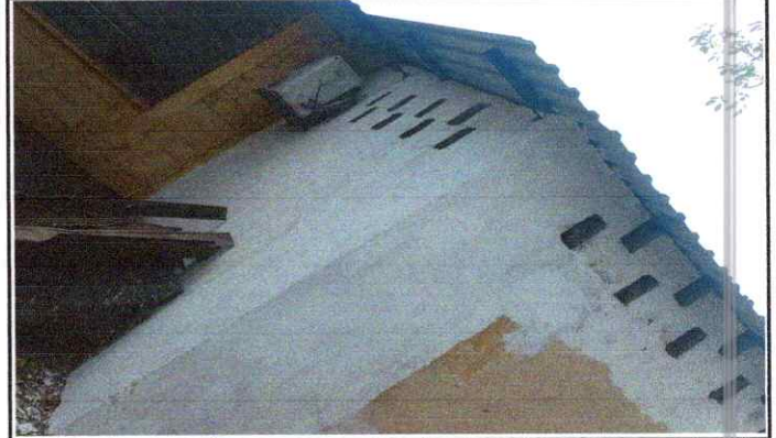
Foto1: 2. CUBIERTA DE LÁMINA
