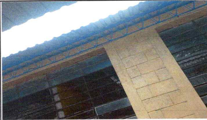
Foto1: 1. CUBIERTA DE LÁMINA
