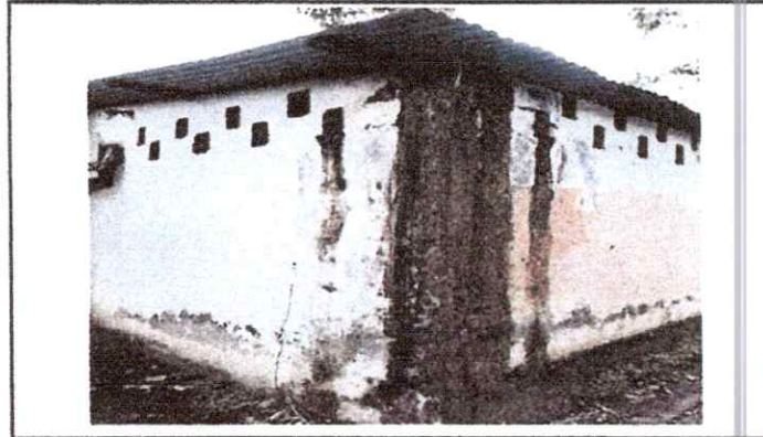
Foto 2: 2. CUBIERTA DE LÁMINA 1.1 Sustitución de lámina por lámina troquelada aluzinc calibre 26 1.2 Sustitución de capote de lámina para lámina troquelada 1.3 Sustitución de elementos de fijación
