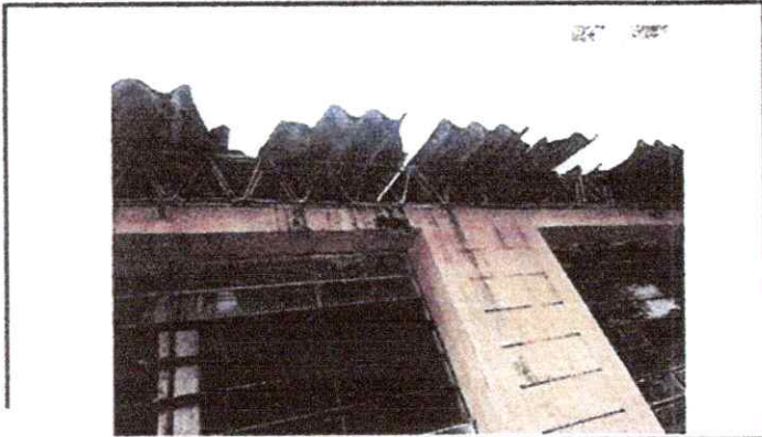
Foto 1: 1. CUBIERTA DE LÁMINA 1.1 Sustitución de lámina por lámina troquelada aluzinc calibre 26 1.2 Sustitución de capote de lámina para lámina troquelada 1.3 Sustitución de elementos de fijación
