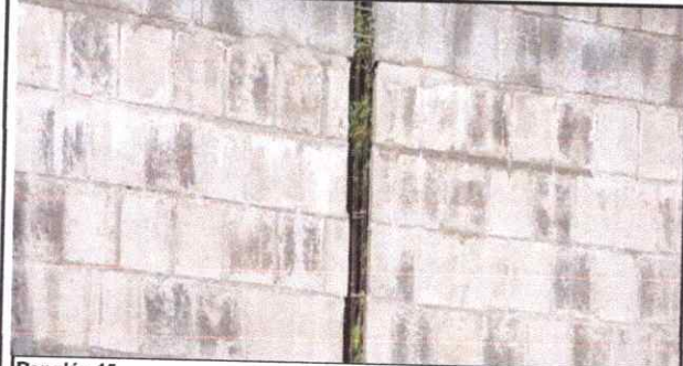
Renglón 15 15.1 Reparación de muro perimetral de block
