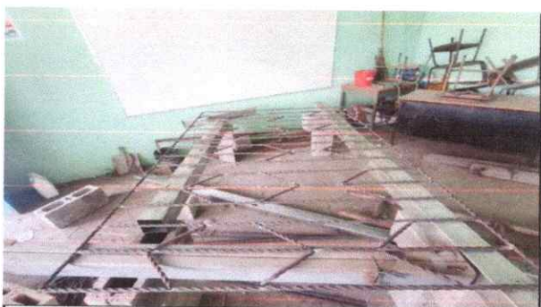
Renglón 5 5,6 Sustitución de balcon de metal
