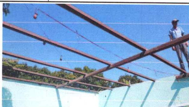
Renglón 1 1.1 Sustitución de lámina, por lámina troquelada aluzinc calibre 26
