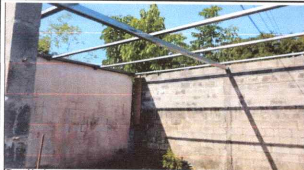
Renglón 1 1.1 Sustitución de lámina, por lámina troquelada azulinc calibre 26
