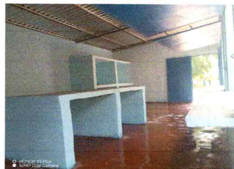
Foto 4: 6.5 Sustitución de piso de torta de concreto
