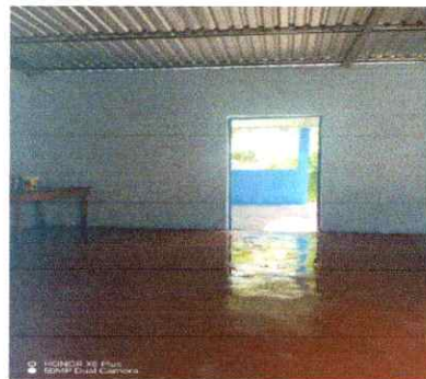
Foto 3: 6.1 Reparación de piso de torta de concreto
