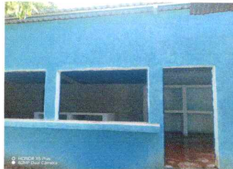
Foto 2: 5.2 Sustitución de estructura de metal de ventana
