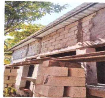
Foto 6: 22.4 Sellado de grietas y fisuras en muros
