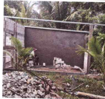
Foto 2: 1 .3 Sustitución de elementos de fijación
