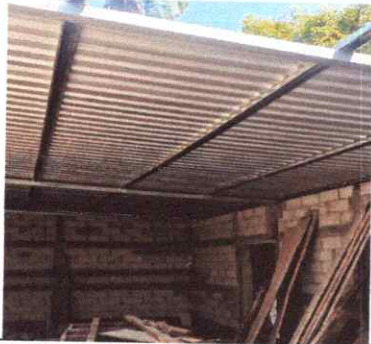
Foto 3: 19.8 Instalación de lámina troquelada aluzinc
