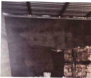
Foto 5: 22.1 Reparación de muros de contención
