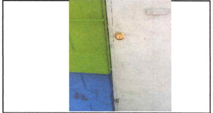
Foto 2. Puertas de metal 4.2 Sustitución de chapa
