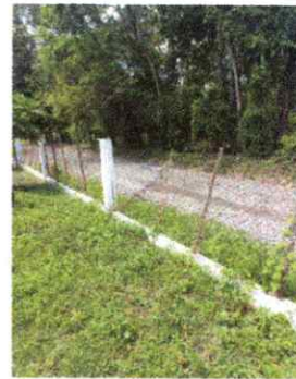
Foto 4: 15 Muros perimetrales 15.2 Reparación de muro perimetral de block con tubo hg y malla galvanizada, soleras intermedias y columnas.
