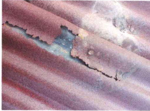
Foto 1: 1. Cubierta de lámina 1.1 Sustitución de lámina troquelada Aluzinc calibre 26. 2. Estructura de techo 2.3 Sustitución de estructura de soporte de metal, por metal.
