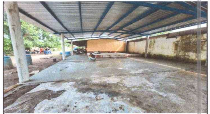
Foto 4: 6. Piso, 6.5. Sustitución de piso de torta de concreto
