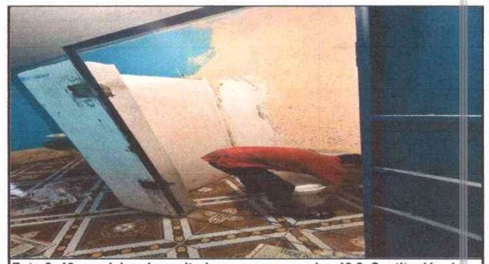
Foto 6: 10. servicios de sanitarios y sus accesorios 10.3. Sustitución de Inodoros
