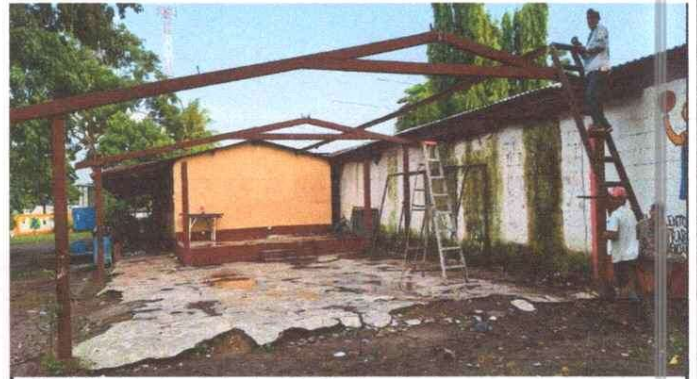
Foto 2: 2. Estructur de techo, 2.3. Sustitución de soporte de metal, por metal.
