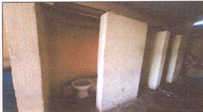
Foto 3: 4. Puerta de metal, 4.4 Sustitución en servicios sanitarios
