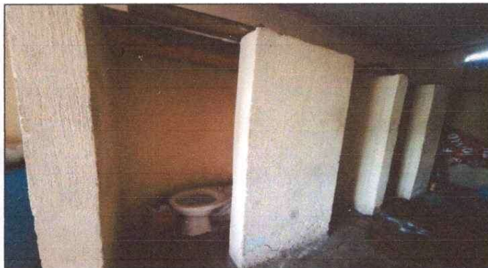
Foto 3: 4. Puerta de metal, 4.4 Sustitución en servicios sanitarios
