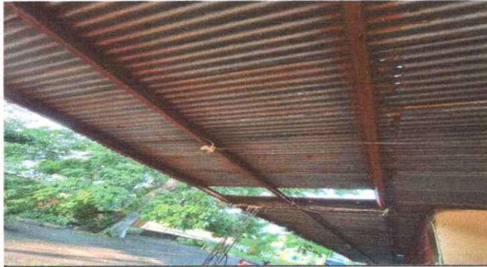
Foto1: 1. cubierta de lamina, 1.1. sustitucion de lámina, por lámiana troquelada aluzinc calibre 2, 1.2 sustitucionde capote para lámina troquelada, 1.3 sustitución de elemento de fijación
