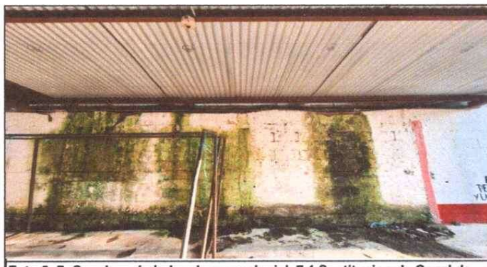
Foto 5: 7. Canales y bajadas de agua pluvial, 7.1 Sustitucion de Canal de Metal
