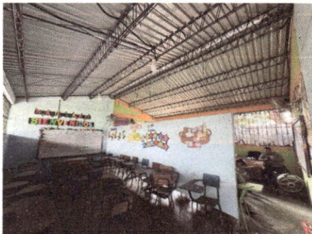
Foto 9: LA ILUMINACION ES COMPARTIDA PARA LAS AULAS
