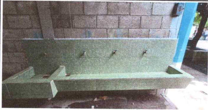
Foto 1: 1.1 Sustitución de lámina, por lámina troquelada aluzinc calibre 26. 2.2 Sustitución de estructura de soporte de metal, por metal 10.5 Sustitución lavamanos
