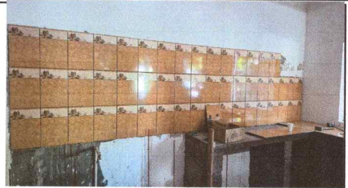
Foto 2: 6.5 Sustitución de piso de torta de concreto 6.8 Sustitución de piso cerámico 13.1 Sustitución de Azulejo
