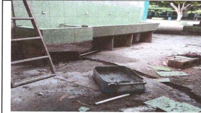
Foto 1: 1.1 Sustitución de lámina, por lámina troquelada aluzinc calibre 26. 2.2 Sustitución de estructura de soporte de metal, por metal 10.5 Sustitución lavamanos
