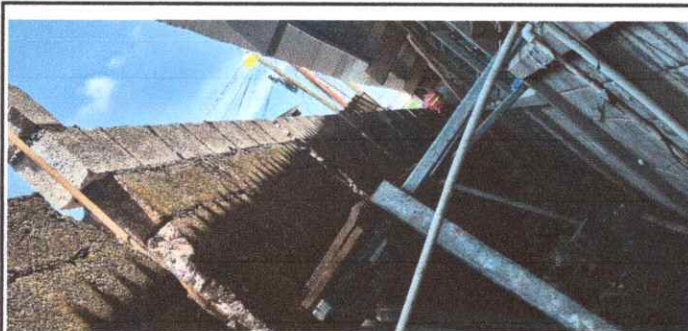
Foto 5: 22.1 Reparación de muro de contención
