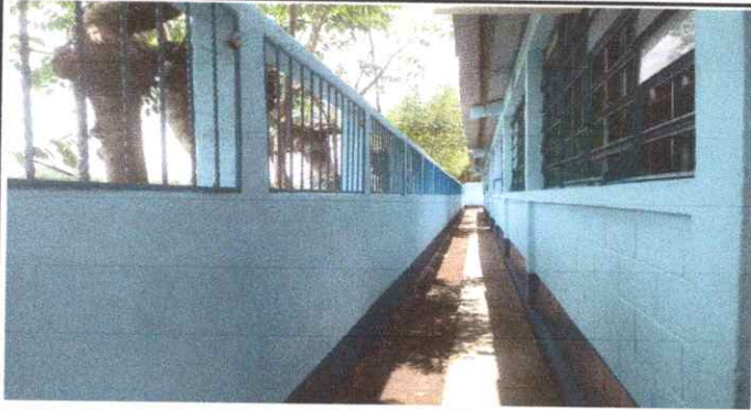
Foto 1: Reparación de muro perimetral de block.
