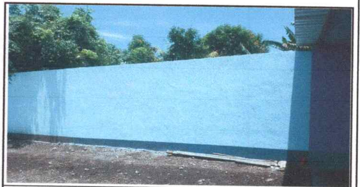
Foto 6: Pintura en muros exteriores e interiores.
