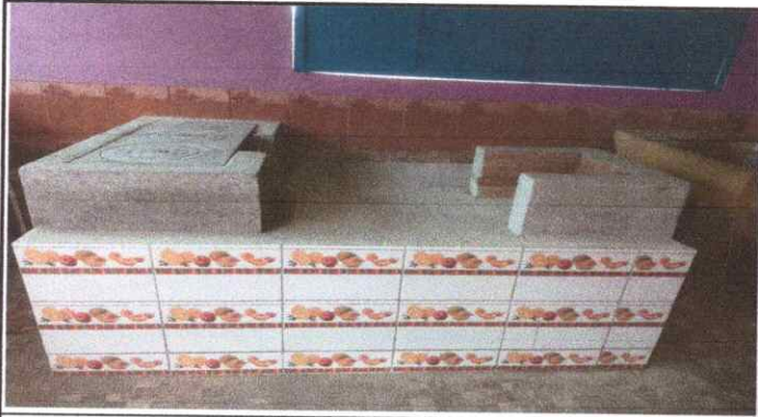
Foto 3: Reparación de cocina (sustitución de planta de metal de tres hornillas).
