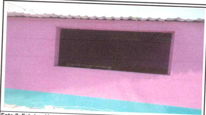
Foto 2: Fabricación e instalación de ventana-Balcón de metal.
