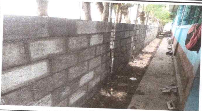
Foto 1: Reparación de muro perimetral de block.
