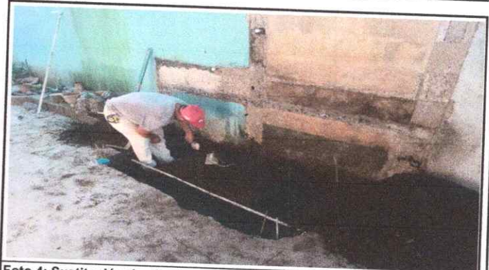
Foto 4: Sustitución de pila de cemento de dos lavaderos.
