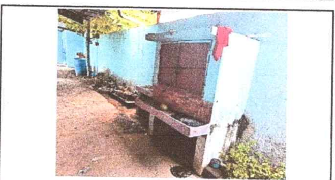
Foto 4: 20.10 Sustitucion de pila de cemento de dos lavaderos.
