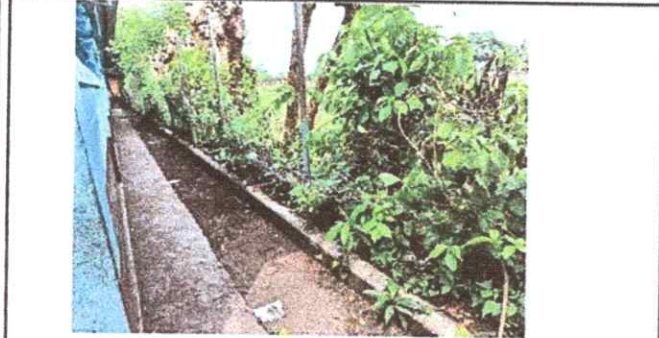
Foto 1: 15. Reparación muro perimetral de block.
