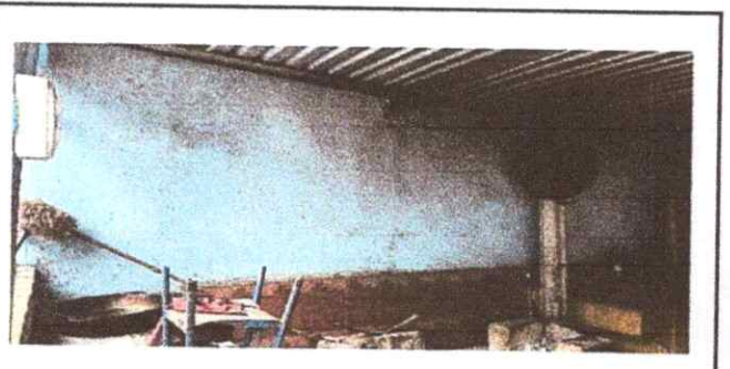
Foto 5: 21. Reparación de repello y cernido de paredes.
