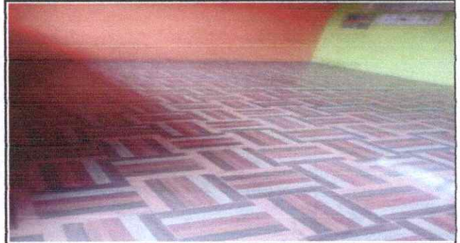
6.8 Sustitución de piso cerámico.
