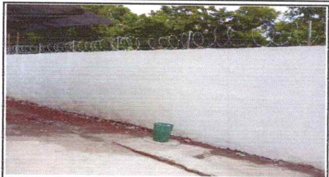
21 Reparación de repello y cernido de paredes. 21.1 Repello en muro.
