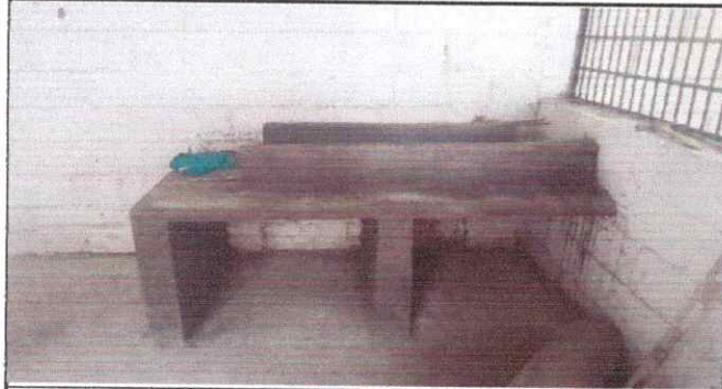
20.3 Sustitución de plancha de metal de 3 hornillas. 20.8 Reparación de azulejo en muebles de cocina.
