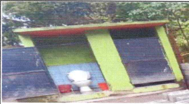
10.3 Sustitución de hinodoro.
