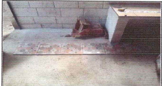
6.8 Sustitución de piso cerámico.
