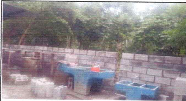
20.10 Sustitución de pila de cemento de dos lavaderos.
