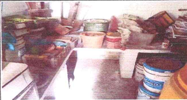
20.3 Sustitución de plancha de metal de 3 hornillas. 20.8 Reparación de azulejo en muebles de cocina.
