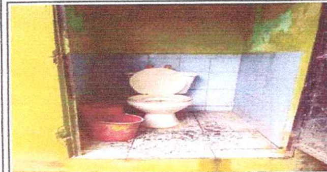
10.3 Sustitución de hinodoro.
