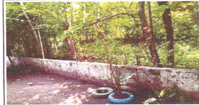
15.1 Reparación de muro perimetral de block
