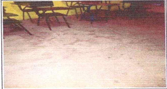
6.8 Sustitución de piso cerámico.
