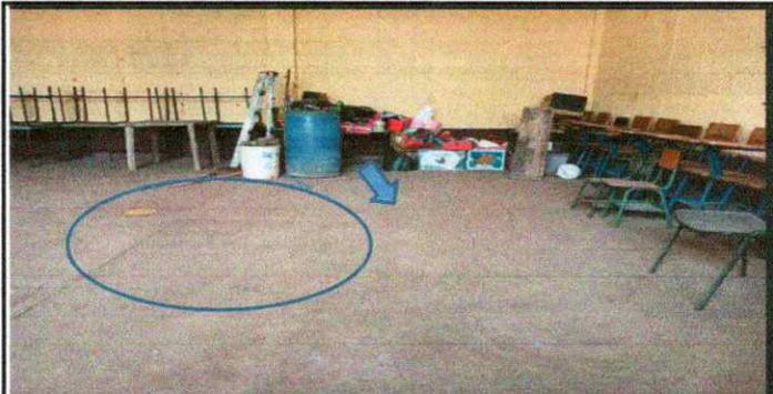
Foto 6: Vista previa del área que necesita mantenimiento por fundición de torta nueva porque se ha levantado plancha fundida de concreto en ésta aula)
