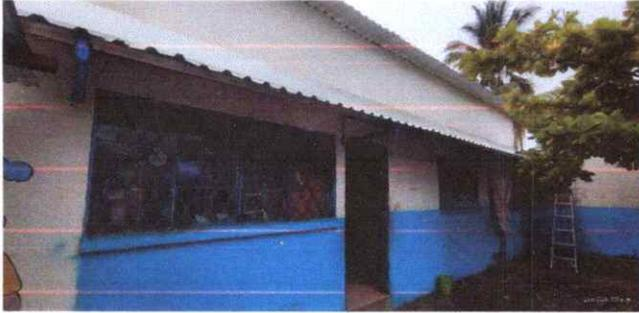
Foto 1: CUBIERTA DE LAMINA / ESTRUCTURA DE TECHO
