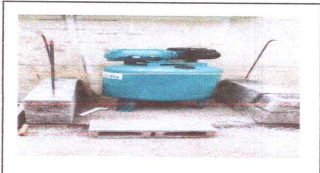
Foto 9: SUSTITUCIÓN DE BOMBA DE AGUA
