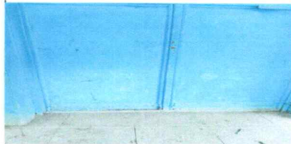
FOTO 4. SUSTITUCION DE PUERTAS
