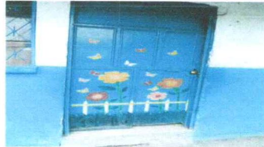
Foto 2: PUERTAS DE METAL/ / MANTENIMIENTO A ESTRUCTURA
