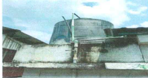
Foto 8: REPARACION Y MANTENIMIENTO DE CISTERNA DEPOSITO DE AGUA
