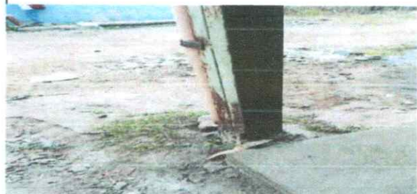
Foto 6: REPARACIÓN TORTA DE CEMENTO
