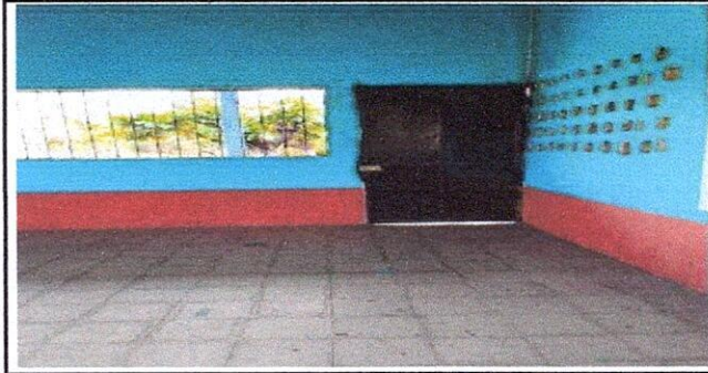
Foto 6: Mantenimiento a estructura metálica en puerta y cambio de pasadores
