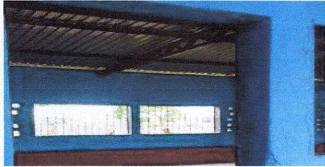
Foto1: Cubierta de lámina salón de aula
