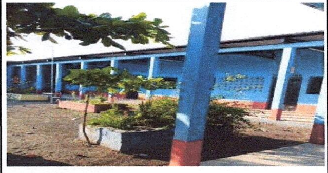
Foto 2: Cubierta de lámina en corredor.
