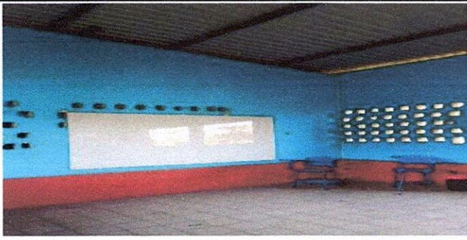
Foto 3: Cambio de estructura metálica corrida
