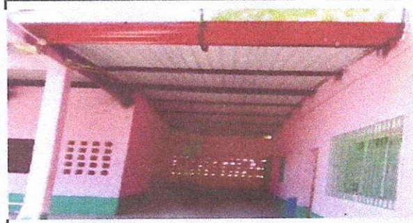
Foto 4: Cubierta de lámina en pasillo
