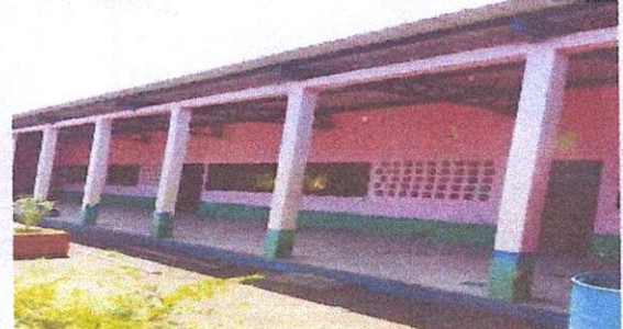
Foto 2: Cubierta de lámina en corredor.
