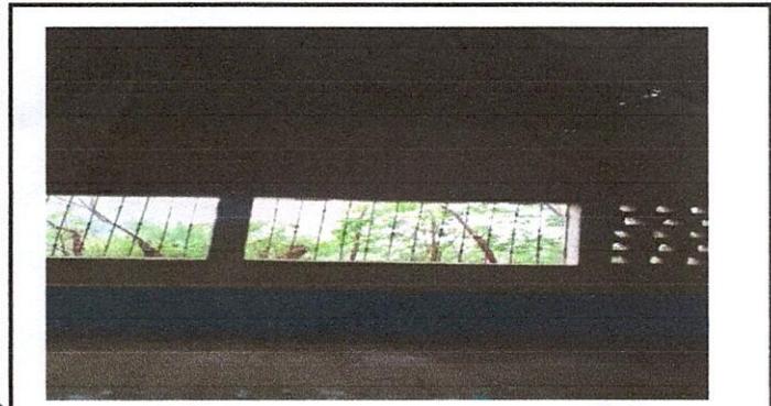
Foto 1: Cubierta de lámina
