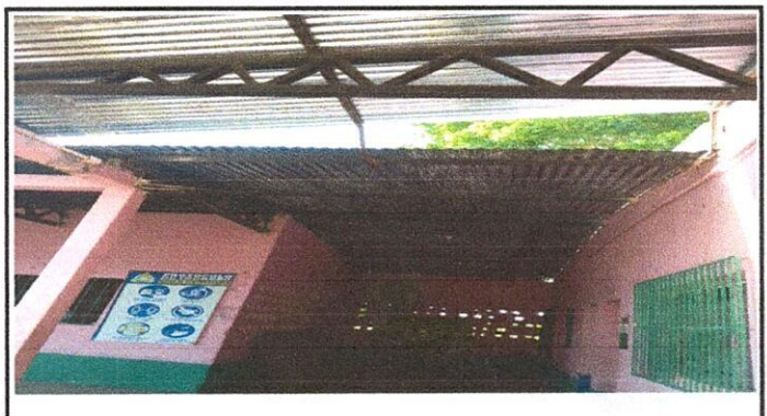
Foto 4: Cubierta de lámina en pasillo
