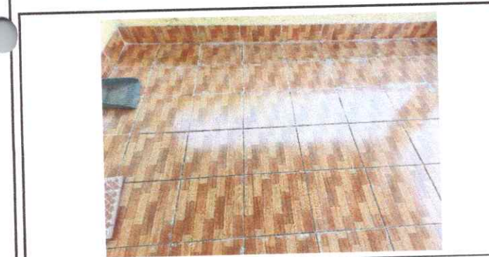
Foto 5: Reparación de piso cerámico
