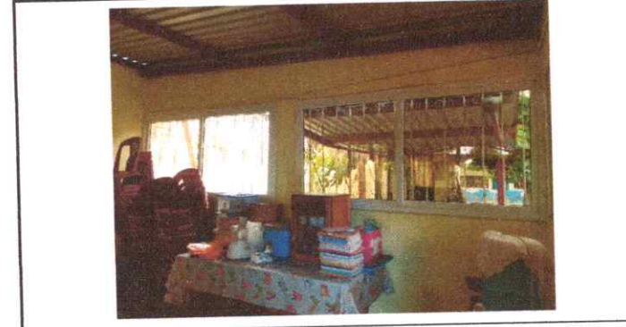
Foto 4: Sustitución de ventana de metal por pvc
