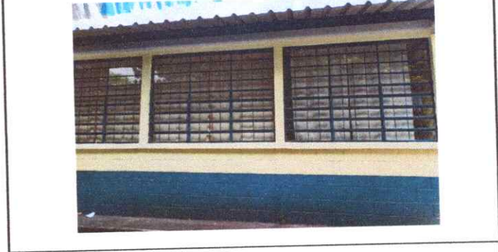
Foto 2: Sustitución de vidrios
