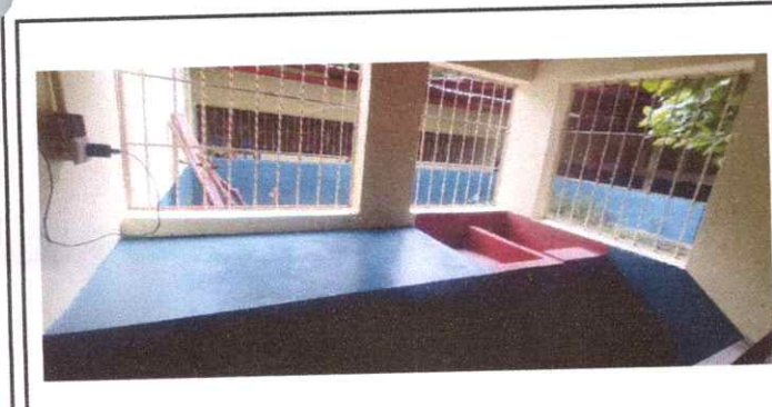
Foto 3: Mantenimiento a balcones de metal
