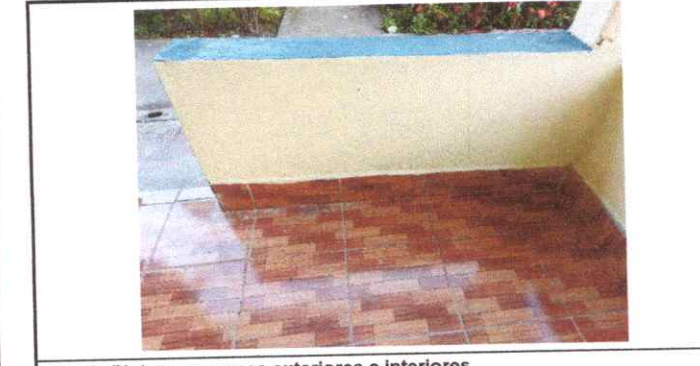
Foto 6: Pintura en muros exteriores e interiores
