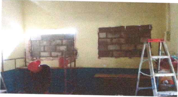
Foto 1: Reparación de muro de block
