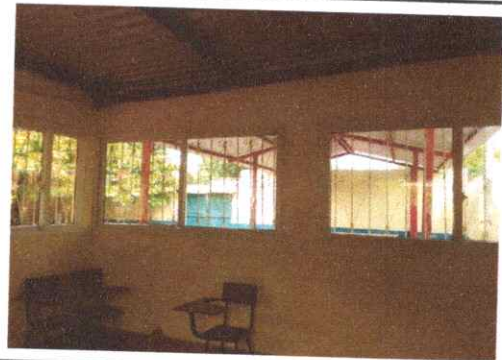
Foto 4: Sustitución de ventana de metal por pvc
