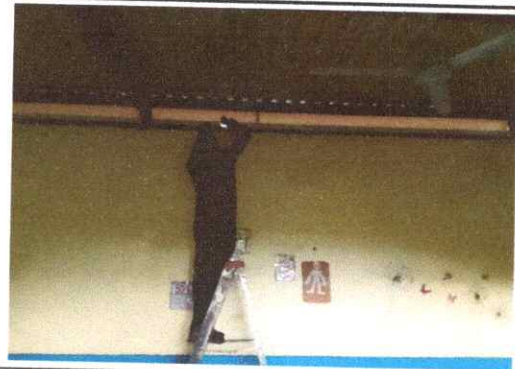
Foto 4: Reparación de repello y cernido de paredes
