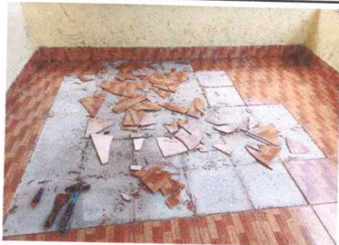
Foto 5: Reparación de piso cerámico
