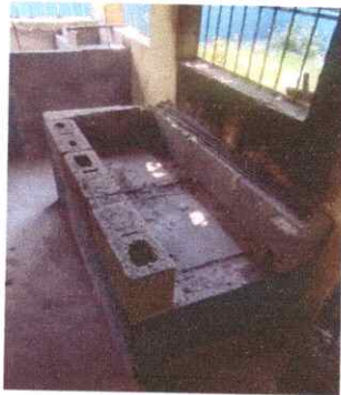
Foto 3: Reparación de cocina
