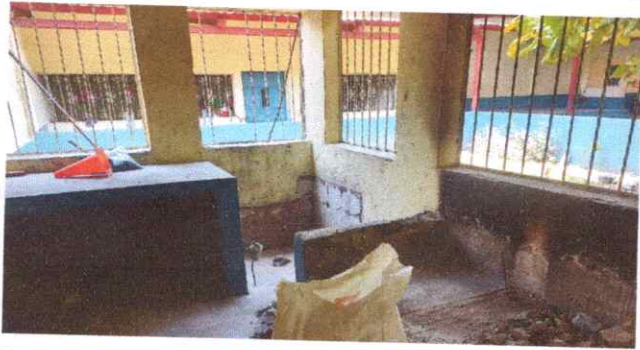
Foto 3: Mantenimiento a balcones de metal
