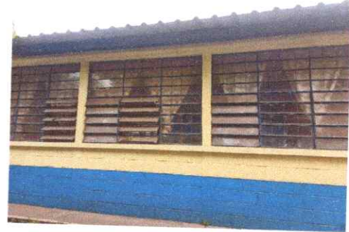
Foto 2: Sustitución de vidrios
