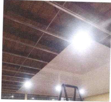
Foto 1: Estructura de techo
