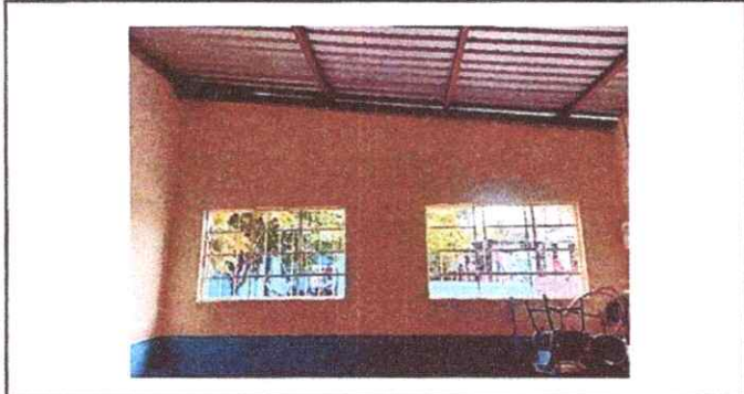
Foto 1: Reparación de muro de block
