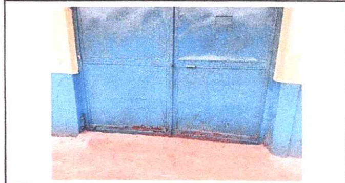
Foto 2: Fabricación e instalación de portón de metal de ingreso
