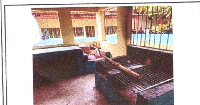
Foto 3: Mantenimiento a balcones de metal
