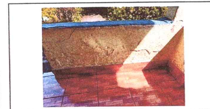
Foto 6: Pintura en muros exteriores e interiores
