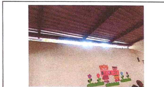
Foto 4: Reparación de repello y cernido de paredes
