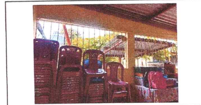
Foto 4: Sustitución de ventana de metal por pvc
