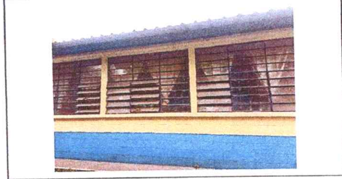
Foto 2: Sustitución de vidrios
