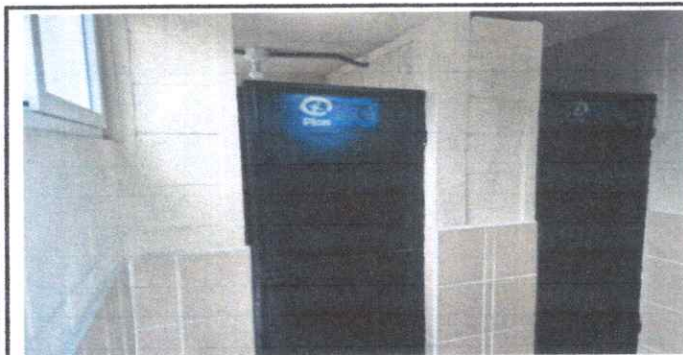
Foto 5: MODULOS DE BAÑOS: Colocación de puertas en los sanitarios.
