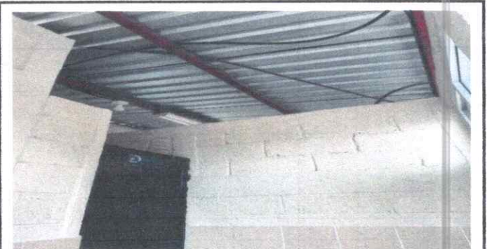
Foto 6: MODULO DE BAÑOS: colocarán estructura metalica y laminas
