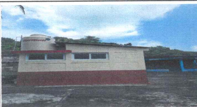
FOTO 3 MODULO DE BAÑOS: colocación de ventanas de pvc.
