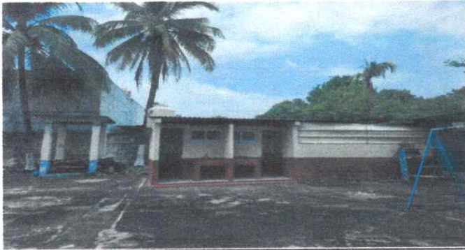
Foto1: MODULO DE BAÑOS: Reparados el segundo juego de baños
