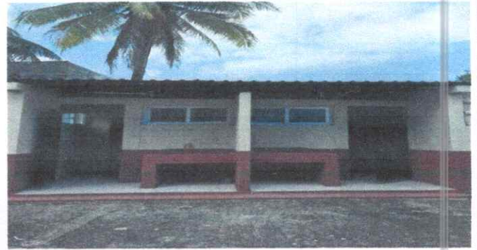
Foto 2: MODULOS DE BAÑOS: Reparados los lavamanos artesanales.
