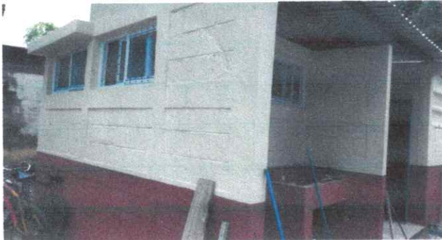
Foto 3: Modulo de baños;colocacion de ventanas de pvc
