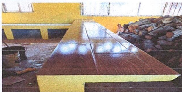
Foto 11: 20.8 Reparación de azulejo en mueble de cocina
