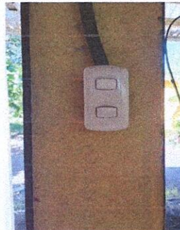
Foto 8: 17.6 Sustitución de interruptores simples
