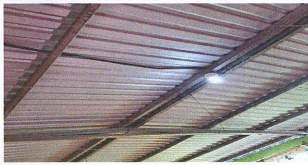
Foto7: 17.4 Sustitución de focos ahorradores (se sustituirán en cuatro salones, dos corredores y la dirección)
