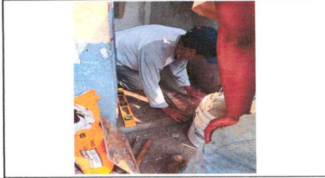
Foto 2: Sustitución de piso ceramico
