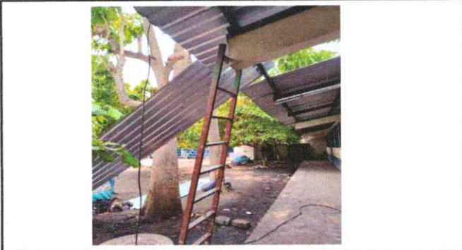
Foto 3: Sustitución de lamina por lámina troquelada
