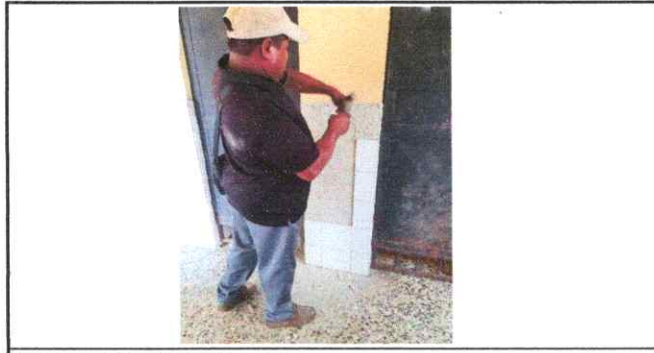
Foto 6: Sustitucion de Azulejos
