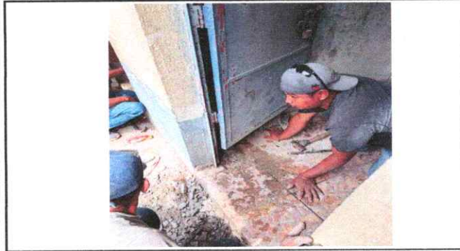
Foto 3: Sustitución de piso cerámico
