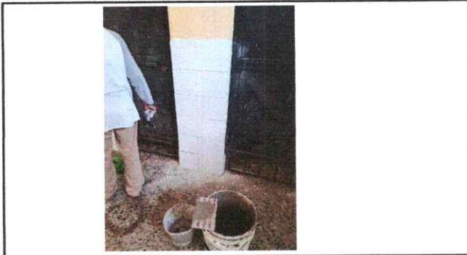
Foto1: Sustitucion de Azulejos
