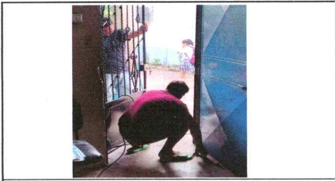
Foto 5: Sustitucion de puertas
