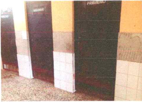
Foto 3: Sustitución de azulejo
