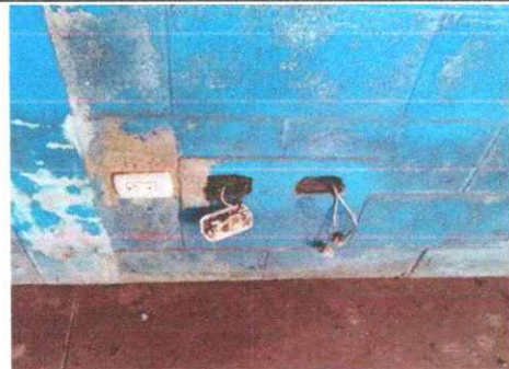
Foto 6: Sustitución de tomacorrientes e interruptores dobles
