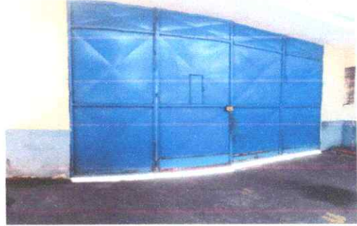
Foto 2: Mantenimiento a portones de metal
