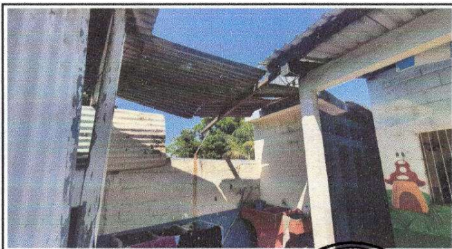
Foto 5: AREA DE BAÑOS Y PILA
