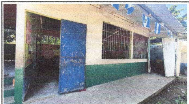
Foto 6: AREA DE AULAS Y BODEGA
