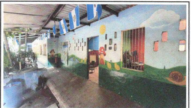
Foto 10: AULAS Y PASILLO
